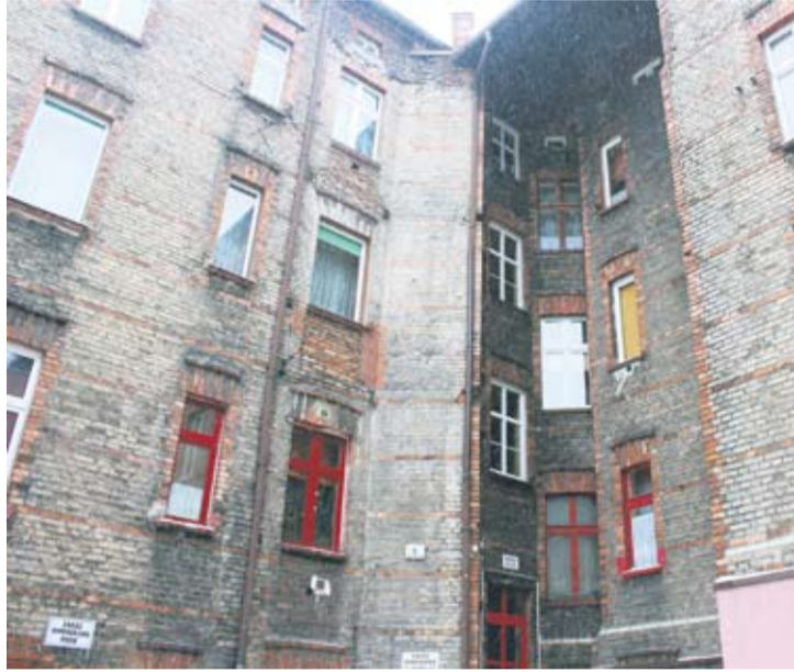
To w tym budynku mogłaby zależeć się kotłownia gazowa.
