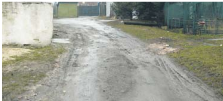
Nawierzchnia drogi jest aktualnie doprowadzana do porządku po tym, jak usuwano awarię kanalizacji. Foto: SH
