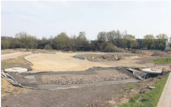
Budowa rond turbinowych zakończy się do połowy września br.
