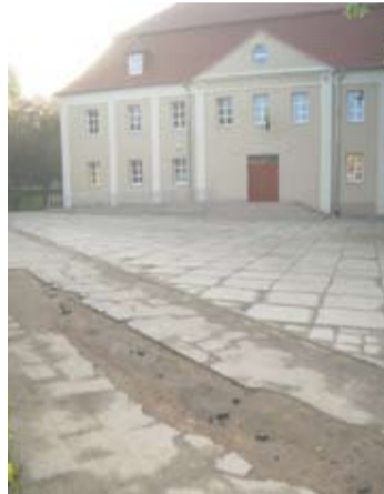
Przy nowo wyremontowanej siedzibie dziurawy chodnik rzuca się w oczy.
