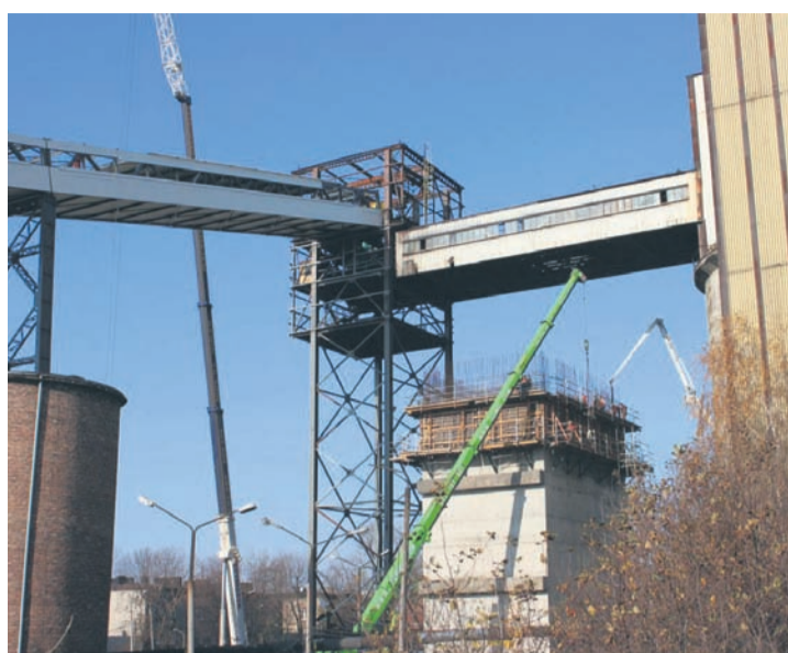
Odgłosy zakłócające spokój mieszkańców osiedla dochodzą z rejonu przebudowanego po zeszłorocznym pożarze taśmociągu. Foto: arch.
