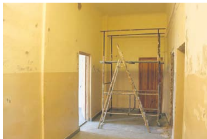
Aktualnie w ZSP nr 4 trwają prace adaptacyjne.
