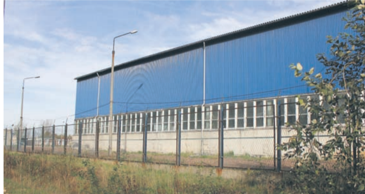
Hala przy ul. gen. Hallera 18 a, w której ma ruszyć inwestycja.
