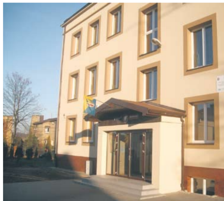
Termomodernizacja Gimnazjum nr 8 kosztowała blisko 1,8 mln zł.
