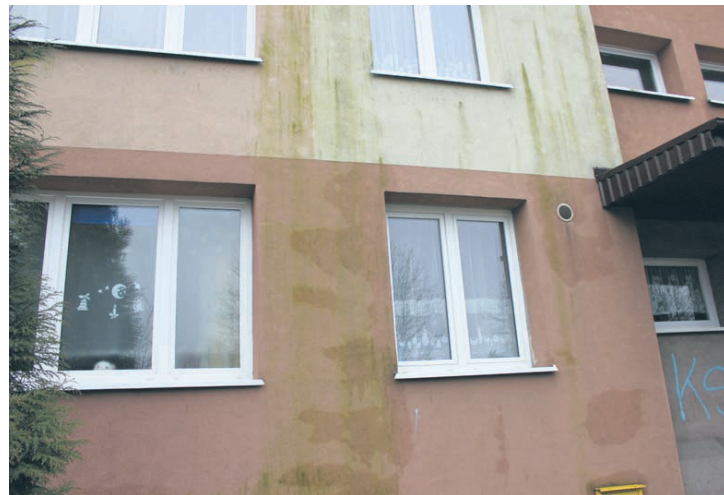
Na elewacji budynku mimo tego, że niedawno został on ocieplony, pojawiły się zielone plamy. Foto: SH
