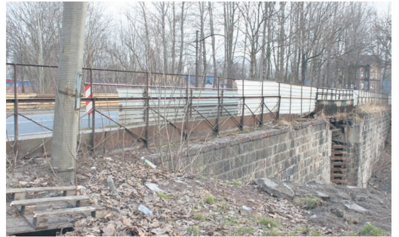
Wiadukt znajdujący się w ciągu ulicy Katowickiej rozbiórany jest w ramach usuwania szkód wyrządzonych działalnością górniczą.
