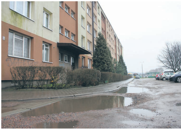
W dziurach znajdujących się na parkingu w trakcie deszczu zbiera się woda.
