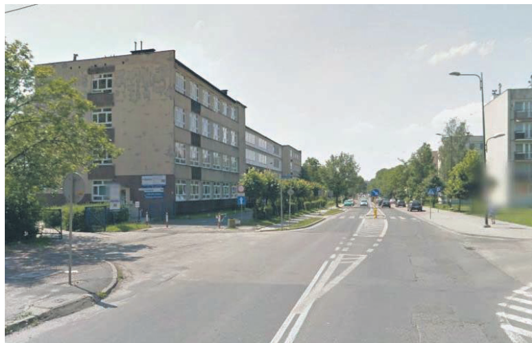
Wykonanie kanału deszczowego w ul. Kłodnickiej zlikwiduje powstawanie zalewisk.
