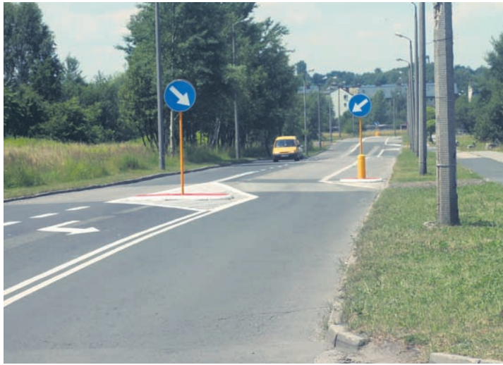
Na ulicy Górnośląskiej zwężono pas jezdni za pomocą oznakowania poziomego.
