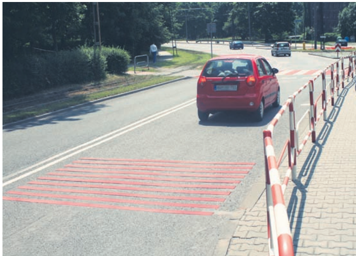
Progi akustyczne mają zwiększyć bezpieczeństwo pieszych.
