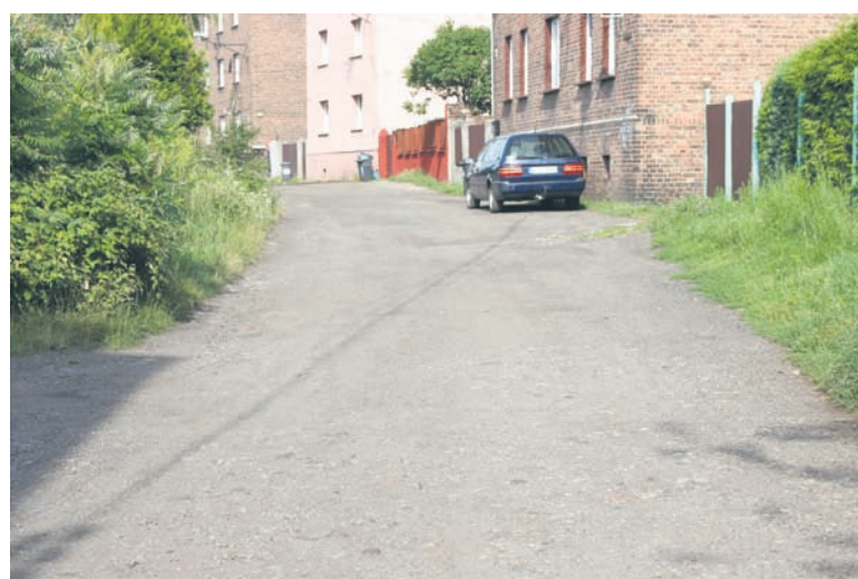
Prace związane z przebudową ul. Wysokiej zakończą się w listopadzie.
