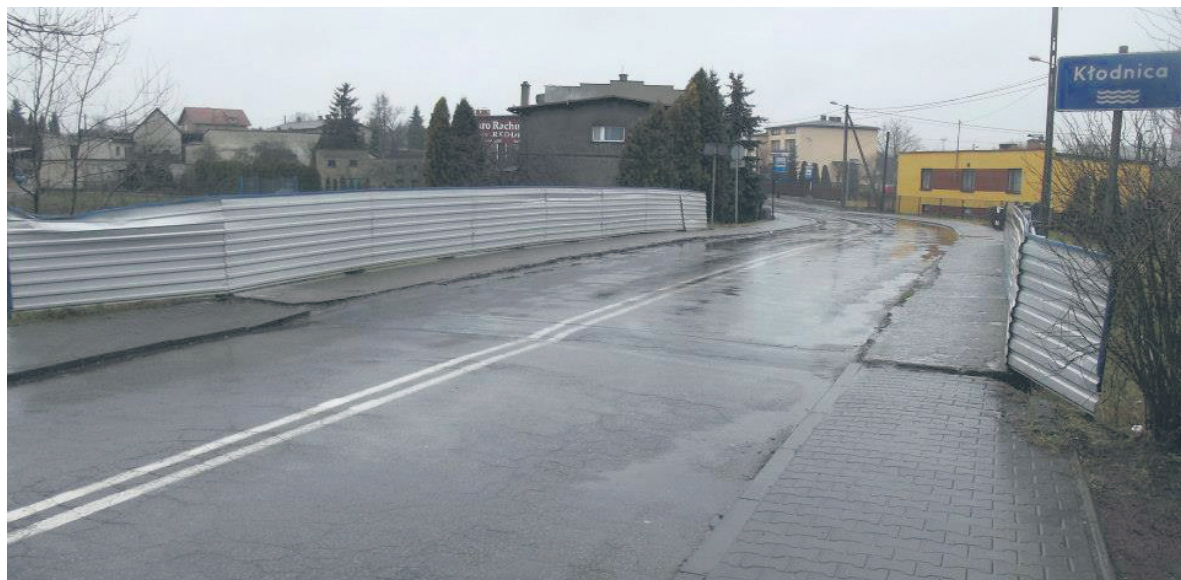
W miejscu robót powróciła już komunikacja zastępcza.
