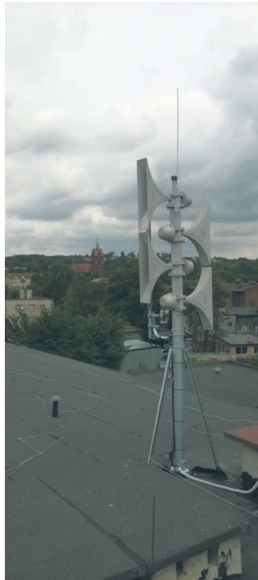
Nowa syrena alarmowa.
