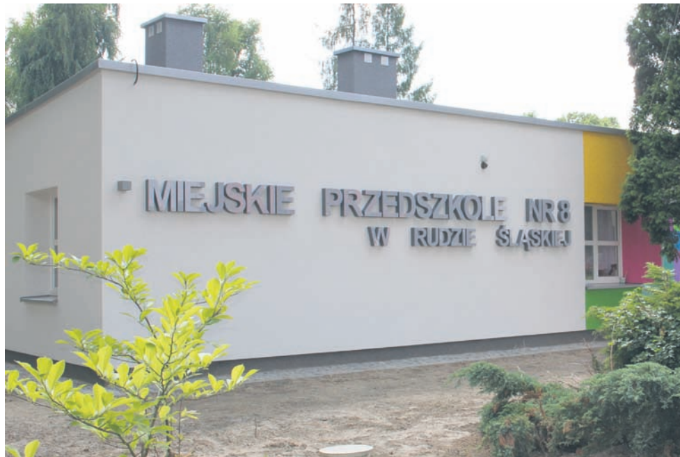
Termomodernizacja przedszkola przy ul. Sobieskiego zakończyła się w lipcu tego roku. Obecnie inwestycje tego typu są realizowane w Zespole Szkół Ogólnokształcących nr 4, Szkole Podstawowej nr 3 oraz Szkole Podstawowej nr 4.
