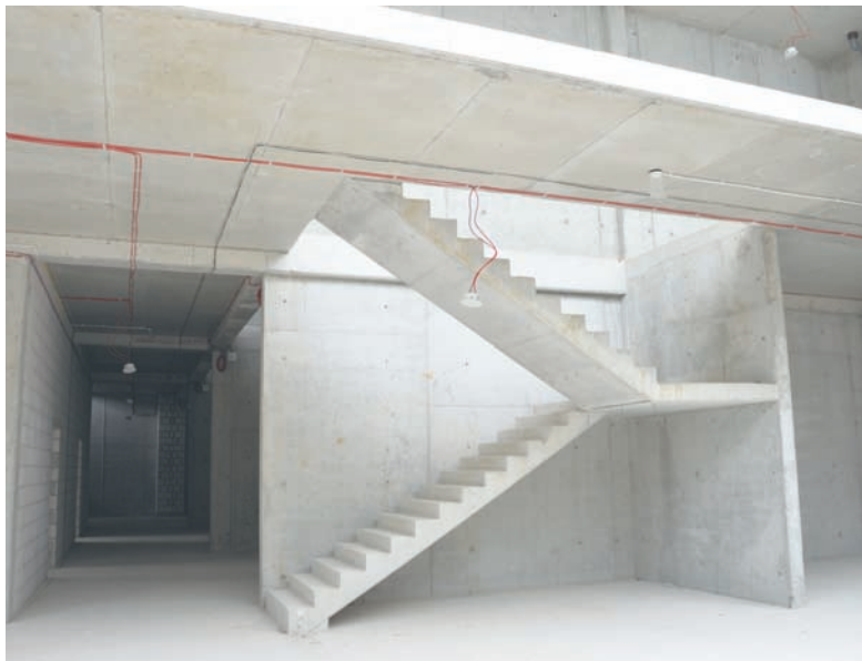
Strefa sucha nadal jest w stanie surowym, choć Aquadrom działa od blisko dwóch lat.
