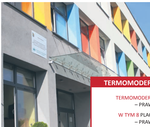
Termomodernizacja Zespołu Szkół Ponadgimnazjalnych nr 2 – 2013 r.
