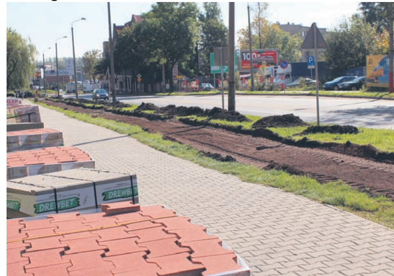
Na razie mamy rozkopane chodniki, ale wkrótce będzie tu ścieżka rowerowa.
