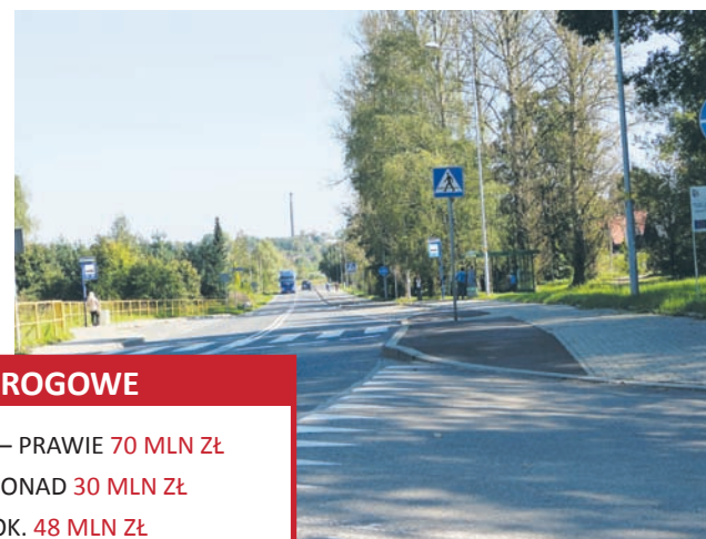
Przebudowa ul. Kokota – 2012 r.
