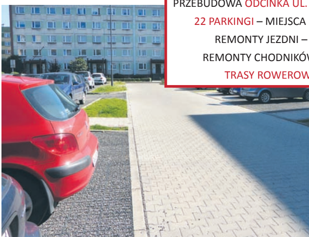
Parking przy ul. Solidarności 10 – 2013 r.
