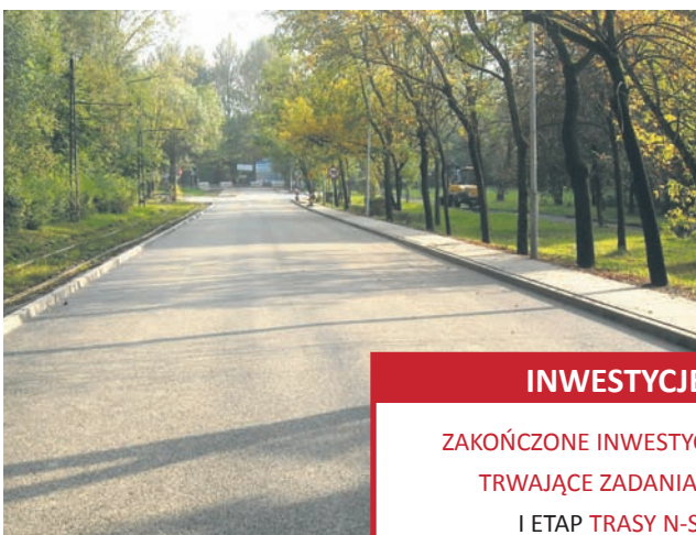
Remont odcinka ul. Karola Goduli – 2014 r.
