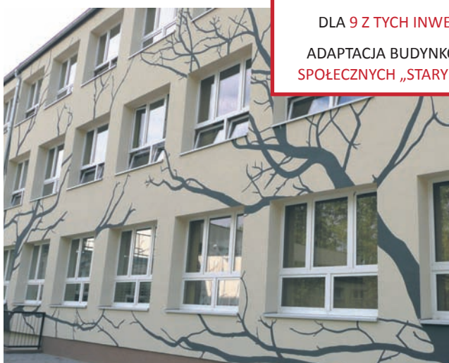
Termomodernizacja Zespołu Szkół Specjalnych nr 2 – 2013 r.
