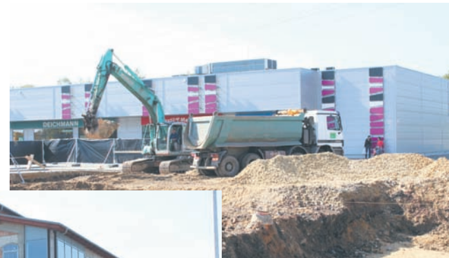
Od kilku tygodni trwa rozbudowa parku handlowego w Bykowninie. Foto: JO
