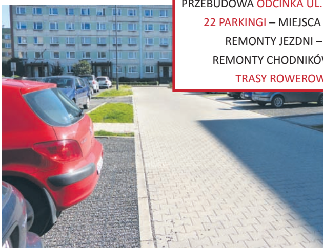
Parking przy ul. Solidarności 10 – 2013 r.
