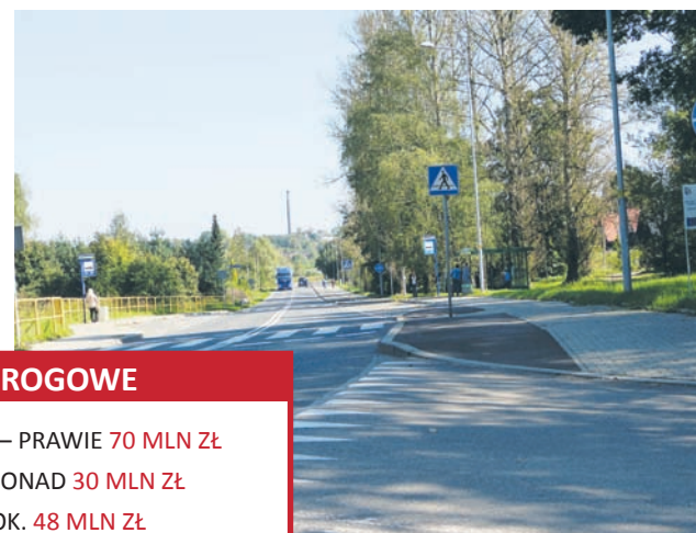
Przebudowa ul. Kokota – 2012 r.
