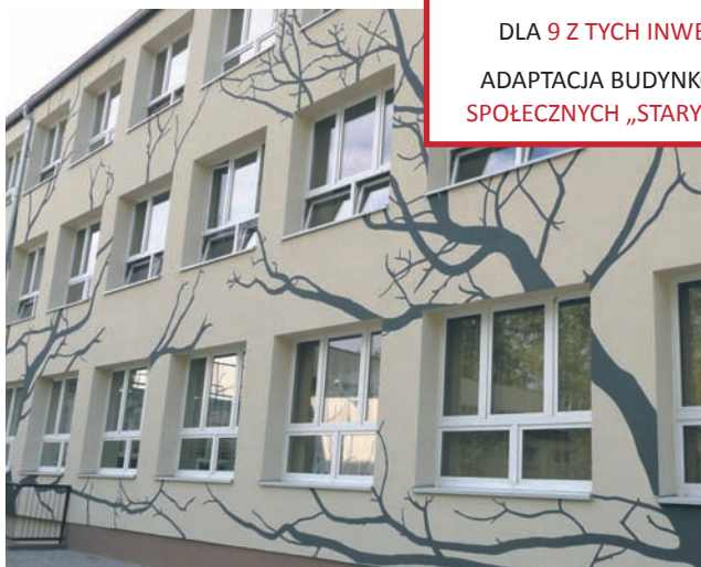
Termomodernizacja Zespołu Szkół Specjalnych nr 2 – 2013 r.
