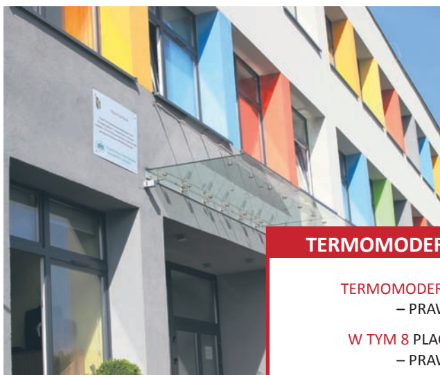
Termomodernizacja Zespołu Szkół Ponadgimnazjalnych nr 2 – 2013 r.
