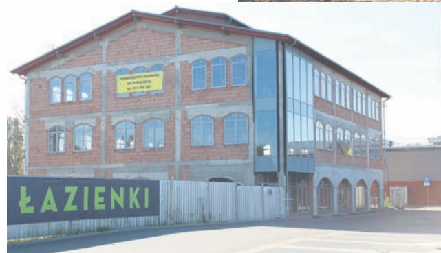
Tymczasem plac budowy Starej Piecowni świeci pustkami. Foto: JO
