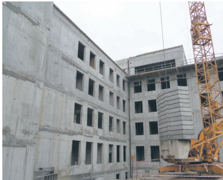
Stanęły już pierwsze mury nowej siedziby Sądu Rejonowego w Rudzie Śląskiej.
