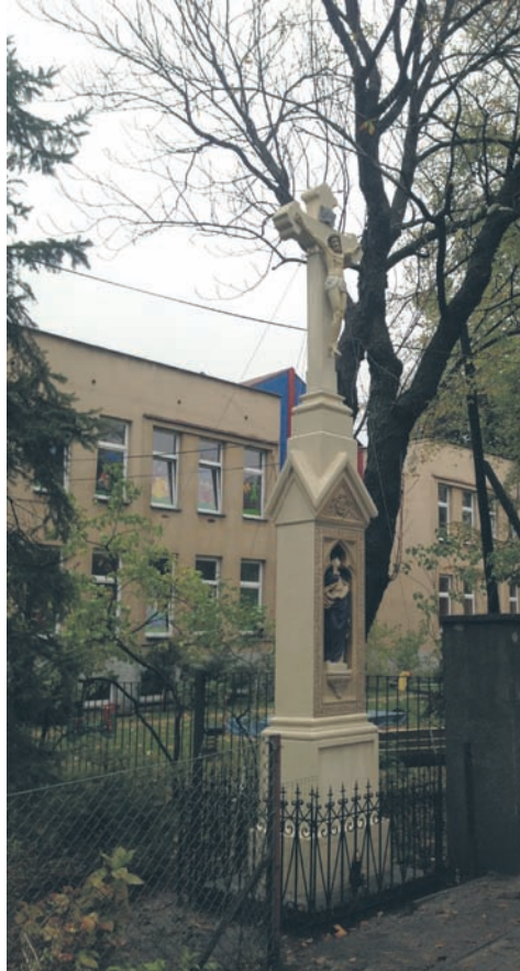
Kapliczkę remontowano trzy miesiące. Niedawno zakończyły się prace. Foto: UM
