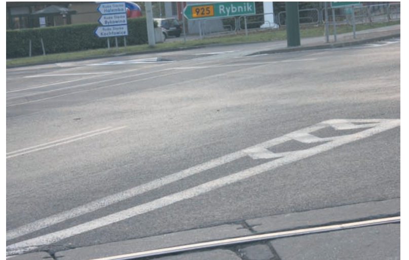
Nawierzchnia wokół torowiska została naprawiona.
