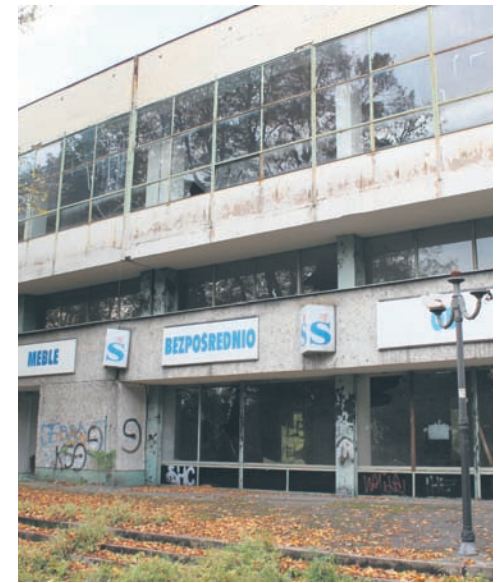
Budynek wymaga generalnego remontu.
