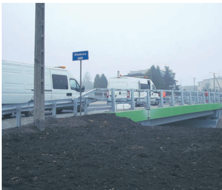
Most zostanie oddany do użytku przed końcem roku.
