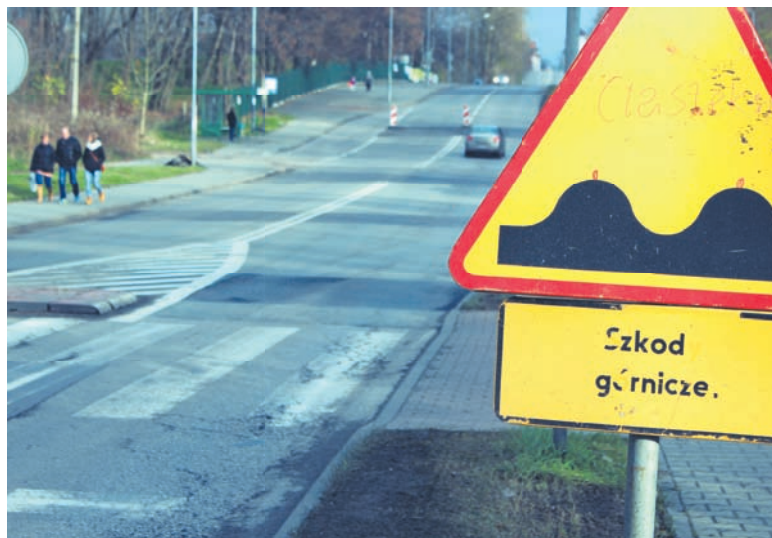
W listopadzie rozpoczął się kolejny remont ulicy Czarnoleśnej.
