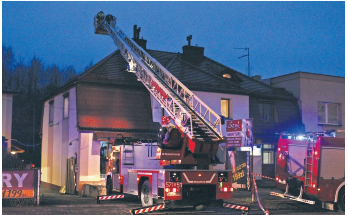
Mocny wstrząs górniczy z 21 listopada sprawił, że popękały ściany budynku przy ulicy 1 Maja 86.
