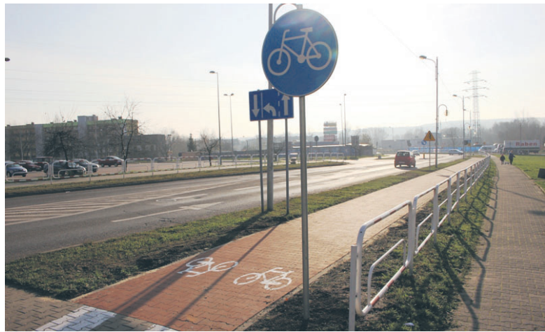
Sieć ścieżek rowerowych wzbogaciła się o kolejny odcinek wzdłuż ulicy Górnośląskiej.
