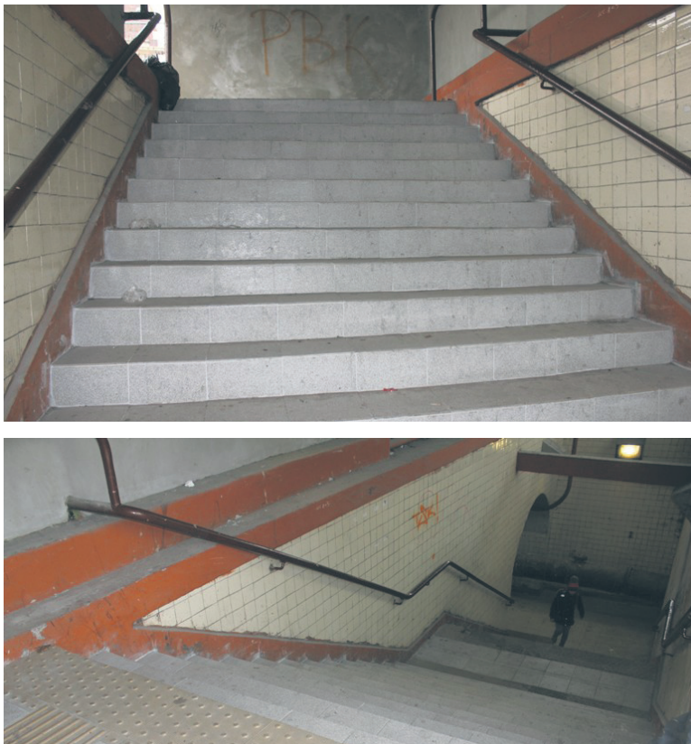
W przejściu podziemnym łączącym ul. Ballestremów i Piastowską brakuje podjazdu dla wózków.
