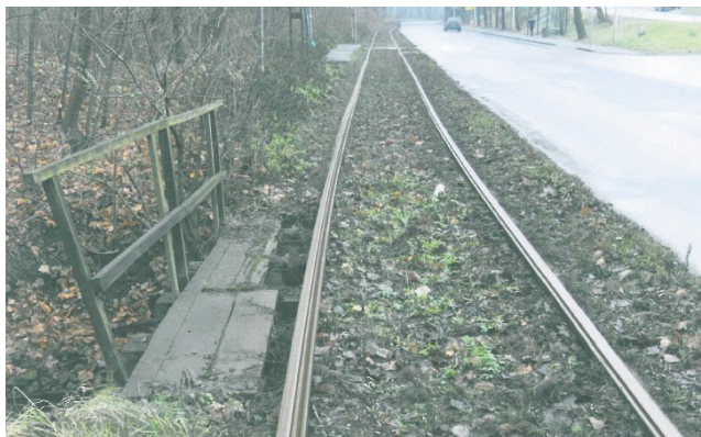
To między innymi fatalny stan torowiska był powodem likwidacji linii tramwajowej nr 18.
