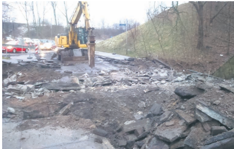
Trwa rozbiórka starego mostu przy ul. Tunkla w Kochłowicach. Roboty potrwać do końca lipca.
