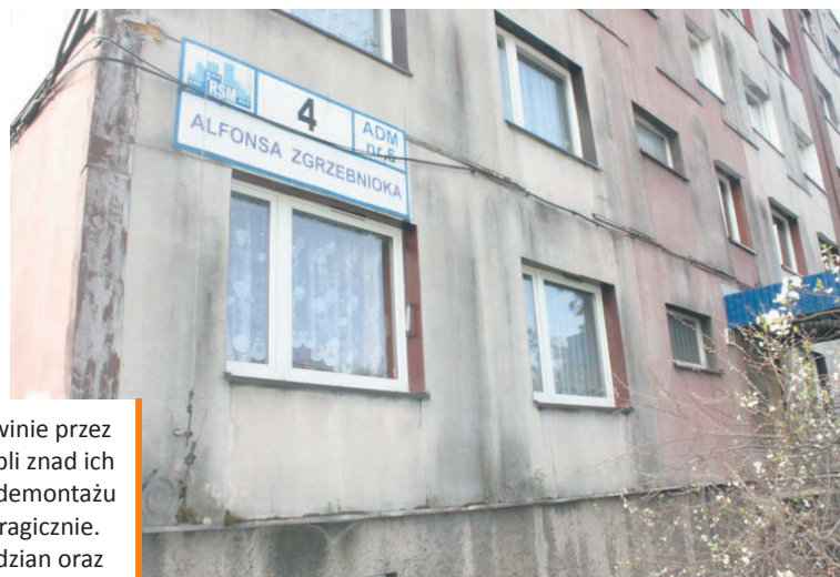
Kable w końcu zniknęły z okien w Bykowie.
