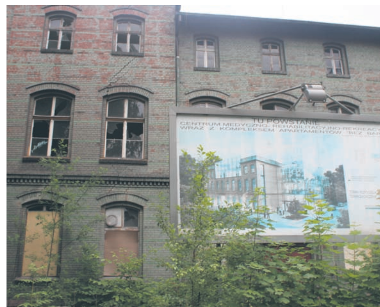
Budynek przy ul. 1 Maja niszczeje od lat.
