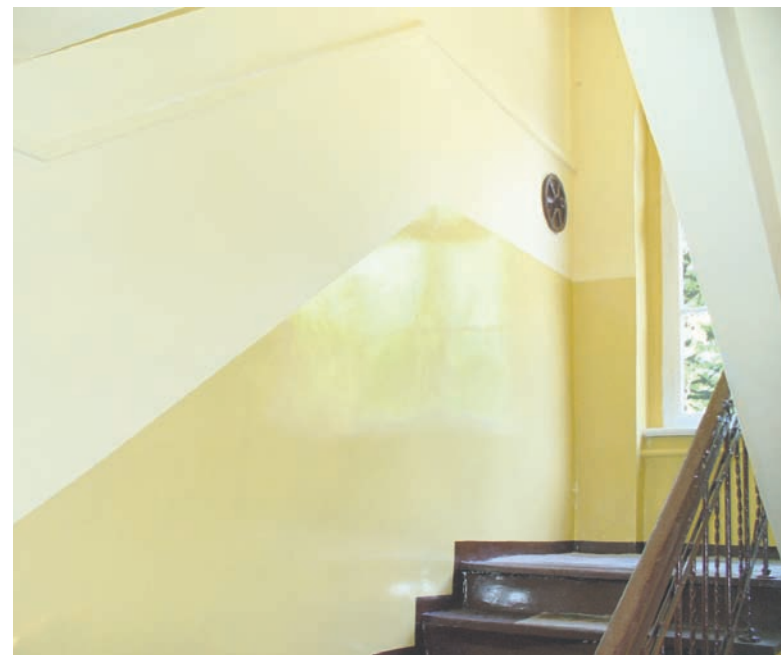
Klatka schodowa wyremontowana została w ramach prac społecznie użytecznych.
