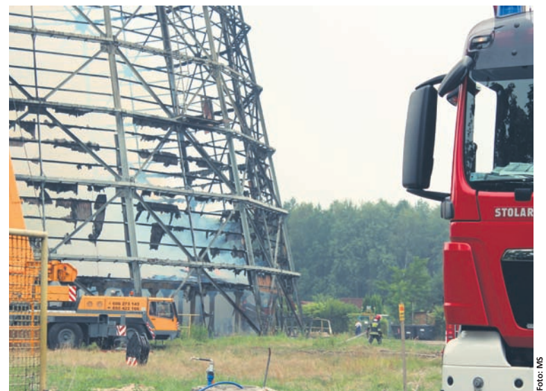
Przy Elektrowni Halemba notorycznie dochodzi do pożarów.
