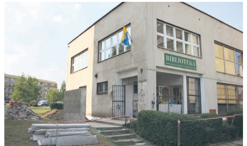
Remont filii nr 21 MBP przy ul. Grzegorzka w Bykowninie rozpoczął się na początku lipca.
