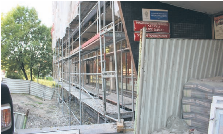
Prace w budynku Zespołu Szkół Muzycznych potrwać do końca roku.
