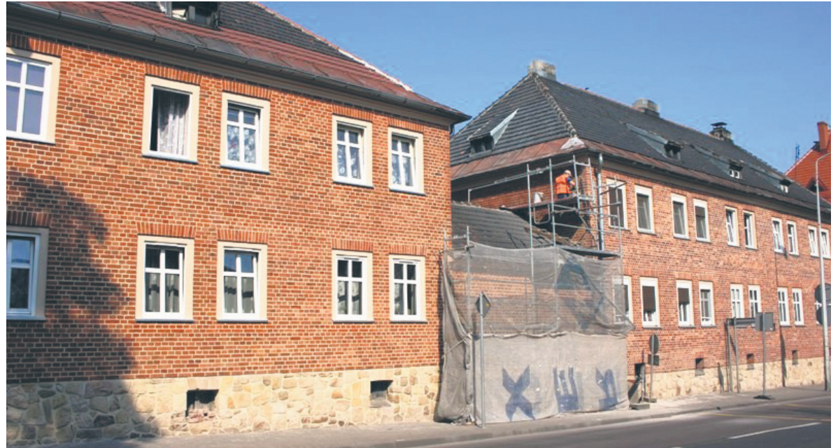
W budynkach przy ul. Wolności trwają prace konserwatorskie polegające na renowacji elewacji.
