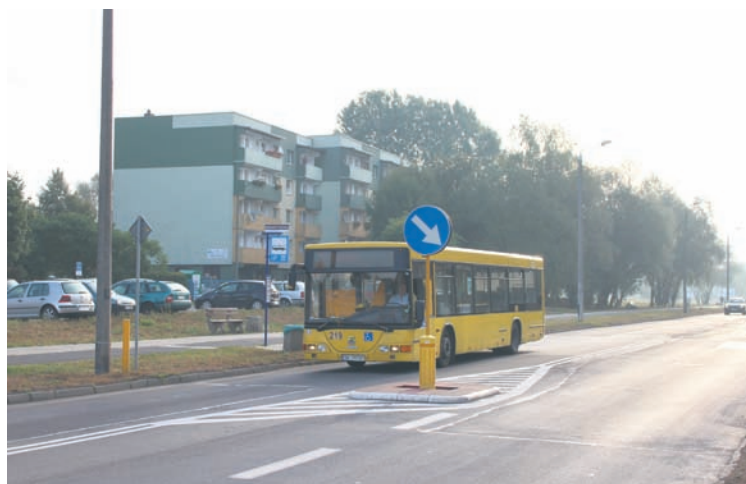
Problem dotyczy przystanku przy ul. Górnośląskiej.
