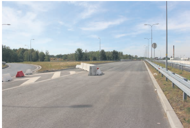
Obecnie trwają prace nad realizacją kolejnych odcinków „eneski”.
