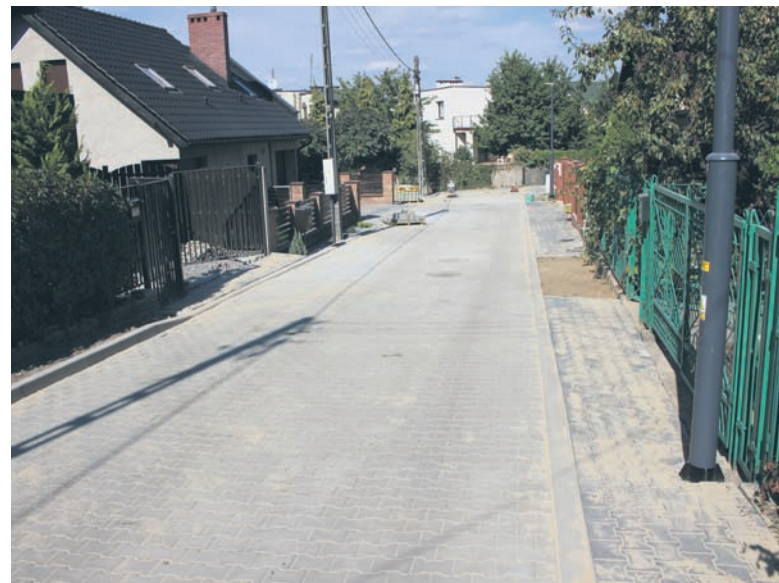
Prace przy ul. Doroszewskiego obejmowały nie tylko wymianę nawierzchni, ale również m.in. wykonanie chodnika do ul. Jesionowej i słupów z oświetleniem LED.
