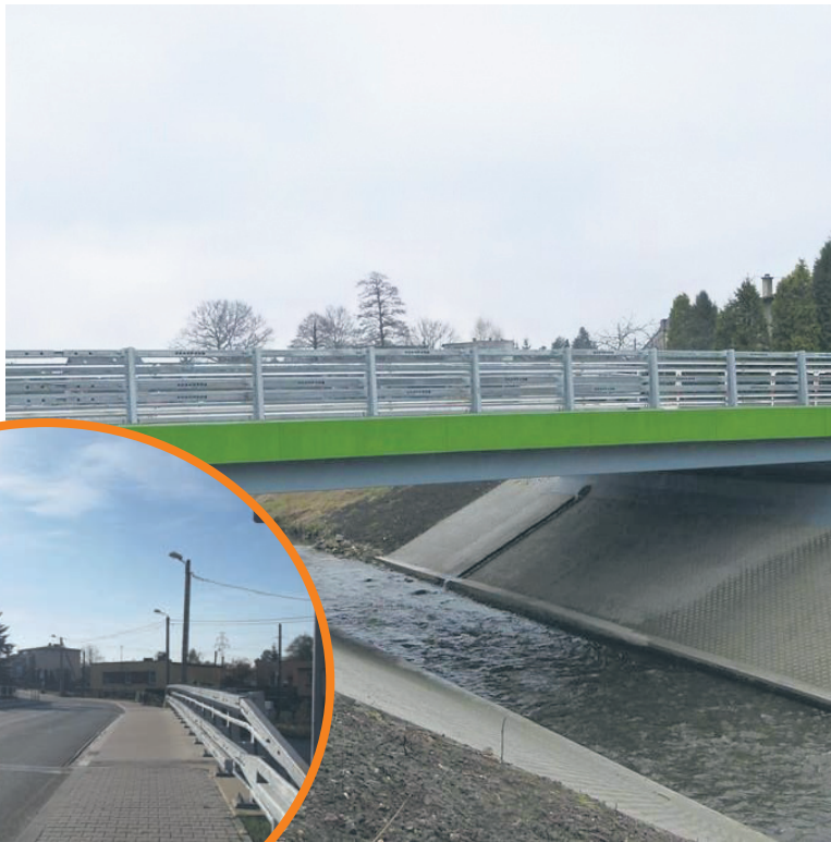
Na budowę mostu zużyto 260 m sześć. betonu.
