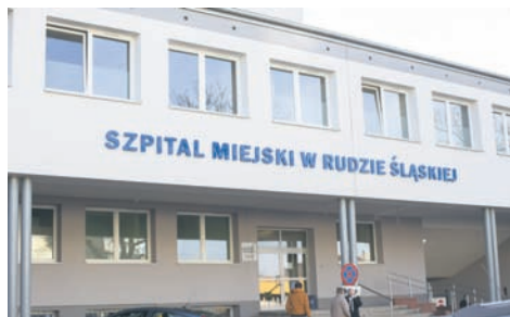
Remont szpitala ma potrwać do końca marca.
