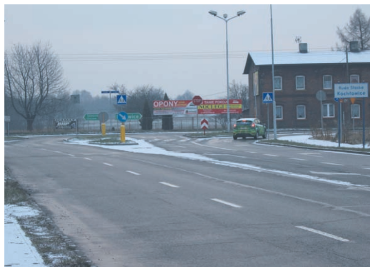
W tym miejscu będzie rozpoczynać się obwodnica Kochłowic.
