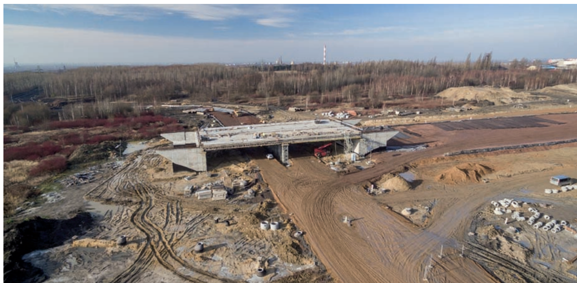
Rozpoczęta w czerwcu ubiegłego roku budowa II etapu trasy N-S zrealizowana jest już w ponad 50 procentach.
