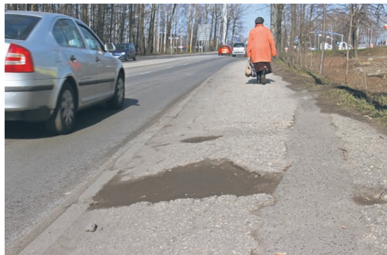
Na remont tego fragmentu chodnika trzeba jeszcze poczekać.
