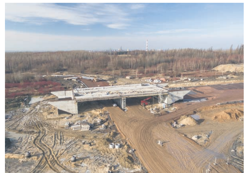
Rozpoczęta w czerwcu 2015 r. budowa II odcinka trasy N-S kosztowała już blisko 30 mln zł.
