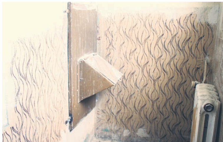
Te zsypy przy ul. Nałkowskiej czekają na remont.
