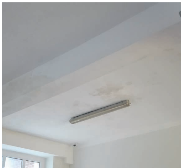
Zdjęcie zalanych ścian nadesłał nasz Czytelnik.
