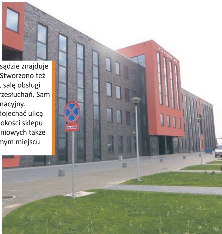
Budynek nowego sądu znajduje się przy ul. Bukowej.
