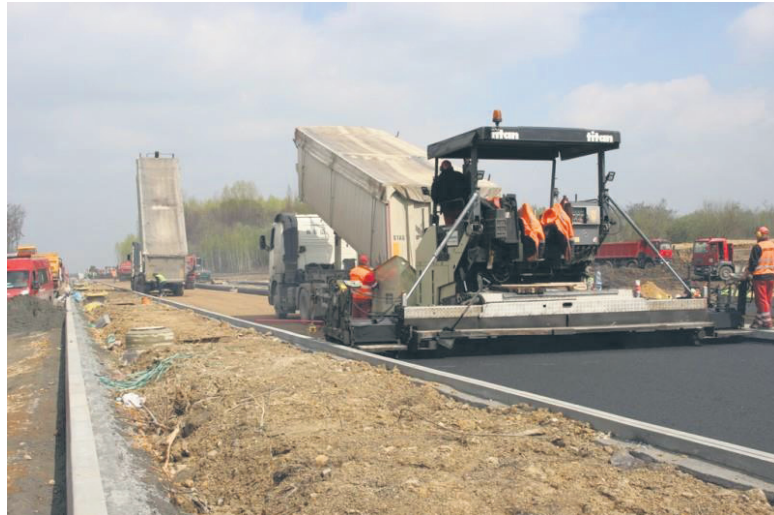
Prace przy budowie kolejnego odcinka trasy N-S są już bardzo zaawansowane.
