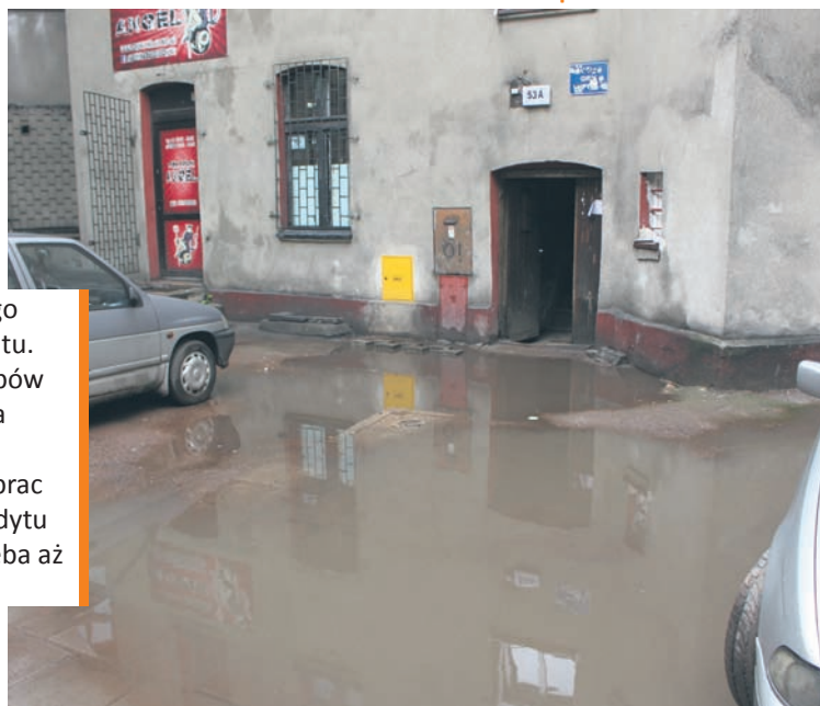
Po deszczu mieszkańcy nie mogą dostać się do klatki schodowej.
