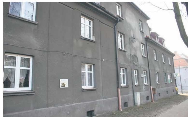
Budynek przy ul. Kokota 133-137 należy do grupy tzw. domów uchodźców.
