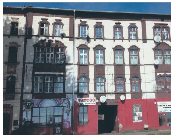
Trwają już prace przy kamienicy mieszkalnej zlokalizowanej przy ul. Katowickiej 45 w Wirku.
