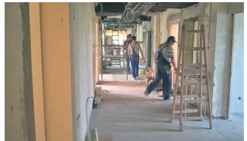
W rudzkim szpitalu trwają już prace remontowo-budowlane.
