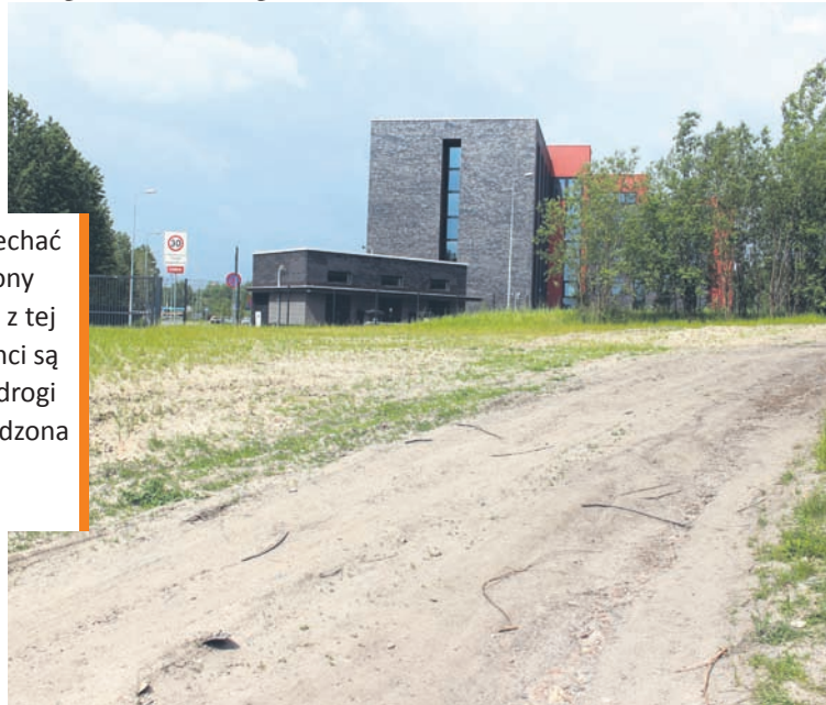
Droga dojazdowa od ul. Glinianej nie jest jeszcze utwardzona.
