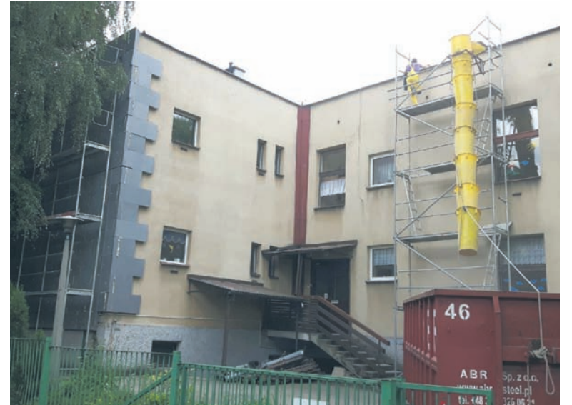
Budynek Miejskiego Przedszkola nr 30 doczeka się m.in. docieplenia, częściowej wymiany stolarki okiennej oraz drzwi zewnętrznych.
