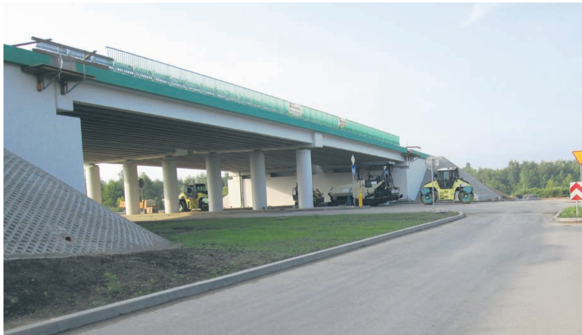
Wiadukt jest już prawie gotowy.
