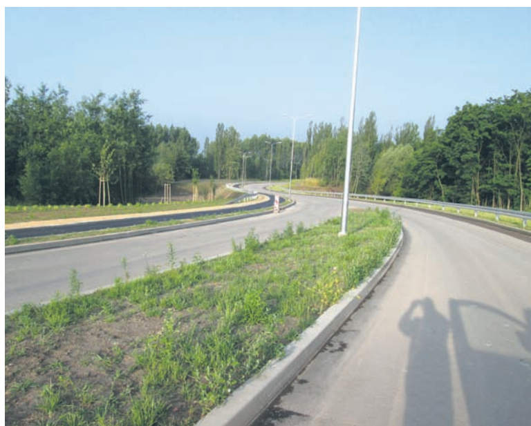
Łagodna zima pozwoliła na znaczne przyspieszenie prac.
