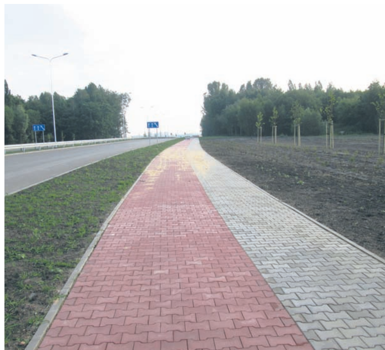
Wzdłuż trasy powstają chodniki i ścieżki rowerowe.
