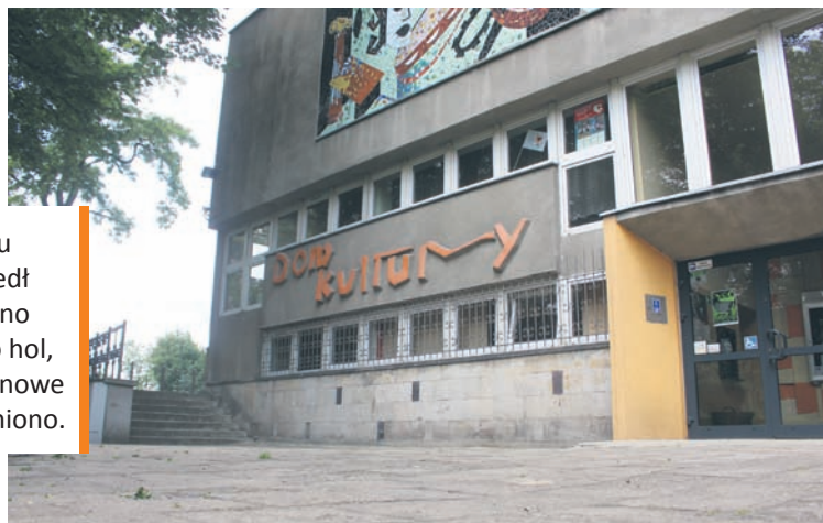
W ramach remontu m.in. wymieniony zostanie chodnik.
