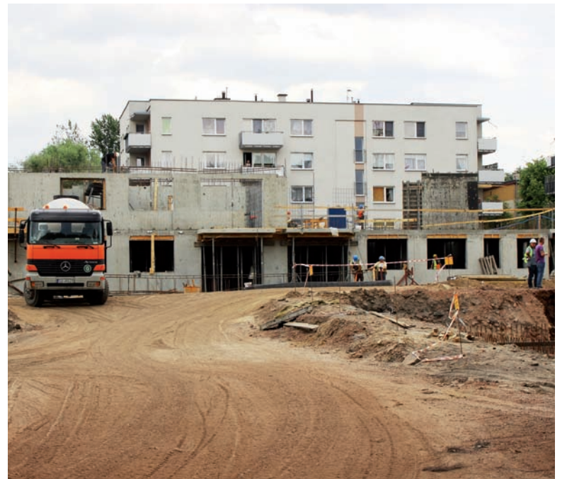
Przy ul. Czempieła trwa już budowa mieszkań w ramach TBS.
