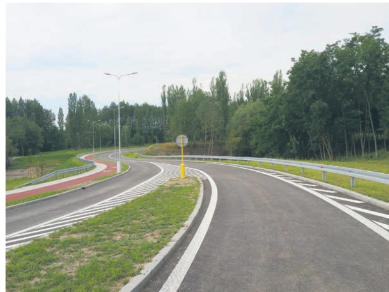
Drugim etapem trasy N-S objęto odcinek od ul. 1 Maja do ul. Bukowej.
