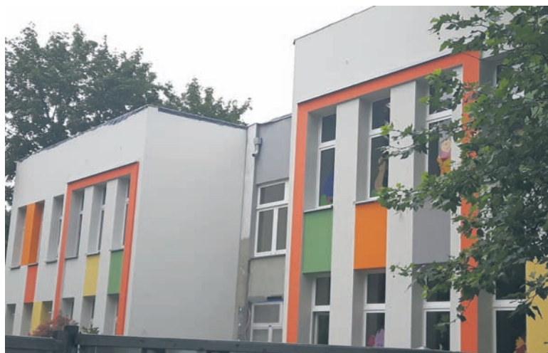
Prace termomodernizacyjne trwają już w MP nr 30.
