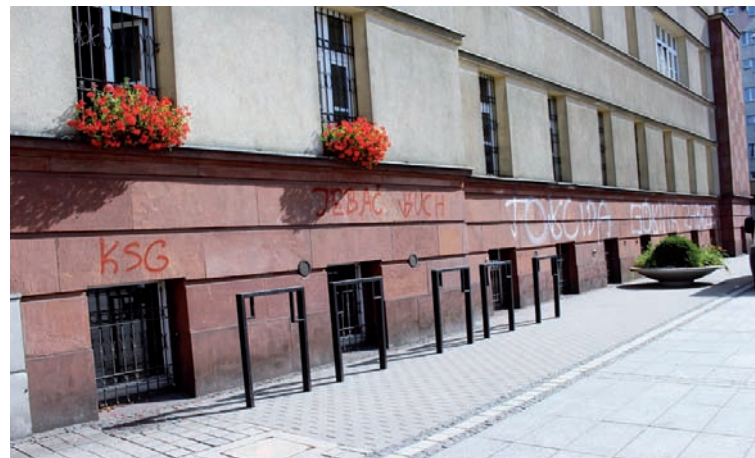
Napisy z elewacji budynku zostały już usunięte.
