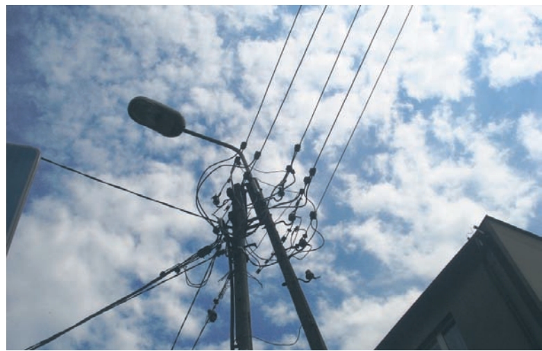
Dzięki wspólnemu zakupowi energii elektrycznej miasto i rudzkie instytucje zaoszczędzą w ciągu dwóch lat ponad 2 mln złotych.
