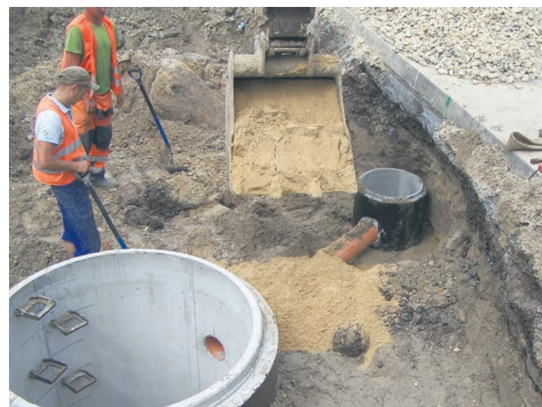
W ciągu trzech lat wybudowana lub przebudowana zostanie sieć wodociągowo-kanalizacyjna o długości blisko 19 km.
